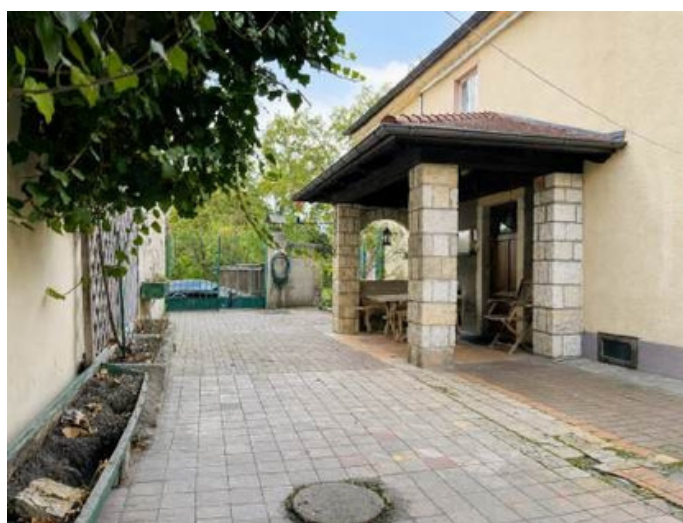
AS Blick Eingang & Einfahrt
